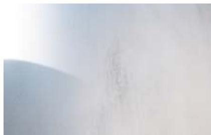
Eingetrocknete Säurereste auf der Bauteiloberfläche durch ungenügendes Spülen
