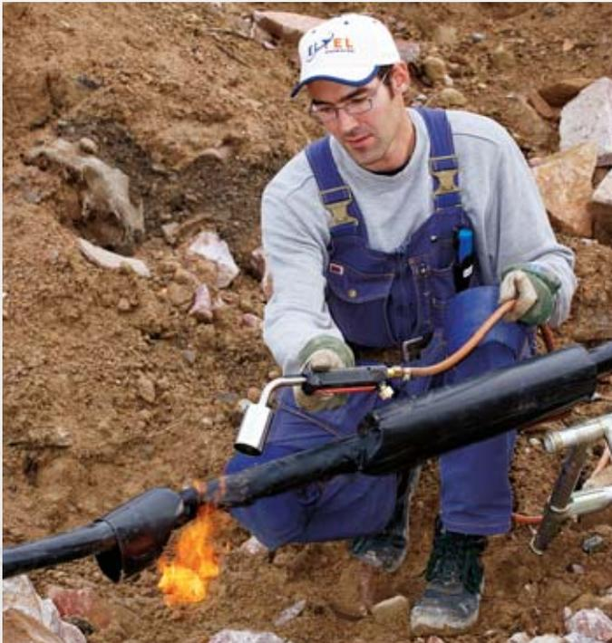
Propanwerkzeuge im Allgemeinen sind bei Handwerkern sehr verbreitet. Sei es zum Hart- und Weichlöten von Rohren und Blechen, zum Erwärmen von Schrumpfmuffen im Kabel- und Leitungsbau, zum Verschweißen von bituminösen Dach- und Dichtungsbahnen oder einfach nur zum Erwärmen.
