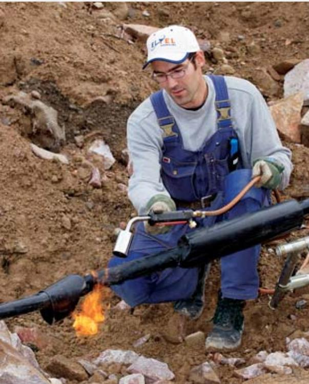
Propanwerkzeuge im Allgemeinen sind bei Handwerkern sehr verbreitet. Sei es zum Hart- und Weichlöten von Rohren und Blechen, zum Erwärmen von Schrumpfmuffen im Kabel- und Leitungsbau, zum Verschweißen von bituminösen Dach- und Dichtungsbahnen oder einfach nur zum Erwärmen.
